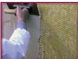
3.6 На внешнюю поверхность плит нанести клеевой состав для базового слоя
