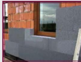
2.4 Приклеивание плит утеплителя на строительное основание
