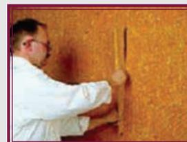
2.10 Зазоры между плитами закрывать фрагментами плит или монтажной пеной
