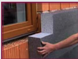
2.8 Диагональные углы оконных и дверных проемов выполнять из целой плиты («сапожком»)
