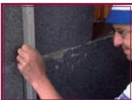
2.6 Контроль неплоскостности наружной поверхности плит с помощью правила
