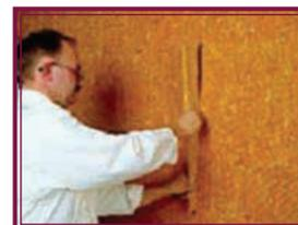
2.10 Зазоры между плитами закрывать фрагментами плит или монтажной пеной
