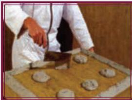
2.2 Нанесение клеевого состава на плиту утеплителя. Метод «валик-точка»
