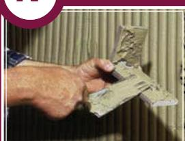
4.1 Клей для керамической плитки наносить одновременно на базовый слой и плитку
