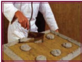
2.2 Нанесение клеевого состава на плиту утеплителя. Метод «валик-точка»
