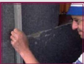
2.6 Контроль плоскостности наружной поверхности плит с помощью правила
