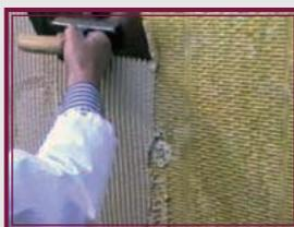
3.8 На внешнюю поверхность плит нанести клеевой состав для базового слоя
