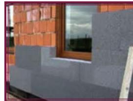
2.4 Приклеивание плит утеплителя на строительное основание
